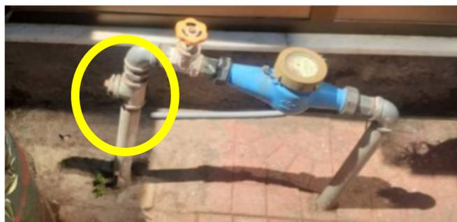
写真 6 水道メーターの上流に分岐がある例
