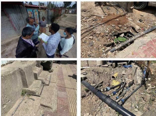
写真 1 露出配管及びスパゲティ管の状況
